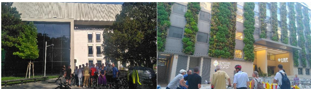
Bilder 4,5: Nachhaltige Gebäude sorgen auch für eine bessere Sommerverträglichkeit wie das Wien Museum und die Barmherzigen Schwestern in der Stumpergasse beweisen. Fotocredits: passathon
