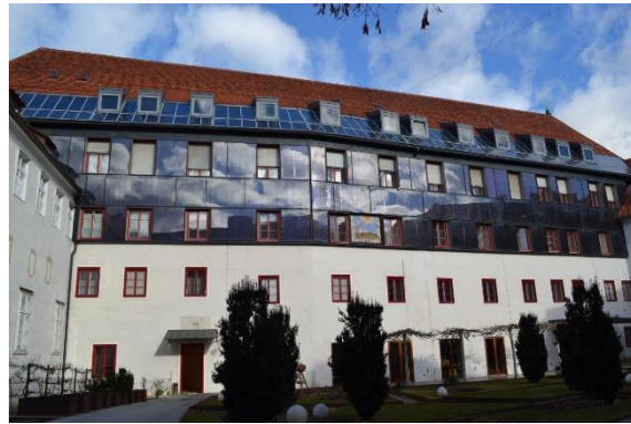
Bild 1+2: Organisator Günter Lang mit Teilnehmern vor dem passathon-Leuchtturm EFH Schwarz in Pettenbach; Das Franziskanerkloster in Graz setzt auf gute Dämmung, Solarthermie und Wärmepumpe statt fossiler Energie; Fotocredits: passathon und Franziskanerkloster Graz
